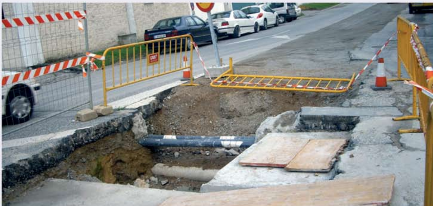
Inicio de los trabajos para la instalación de nuevas tuberías con mayor capacidad para recoger aguas pluviales.
